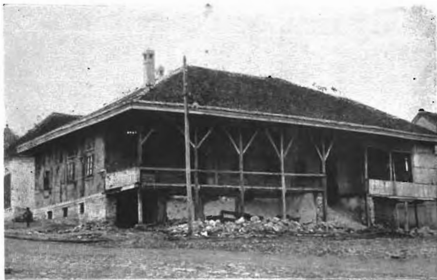
Сл. 4. Хан у Сопоту (1838) — током рестаурације Fig. 4. Inn ( han ) in Sopot (1838) — in course of restoration
