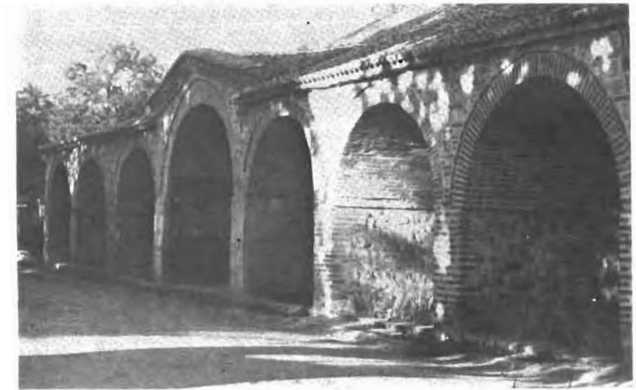
Сл. 2. Арсенал у Нишкој тврђави — некадашњи хан (XVI век), пре рестаурације. Fig. 2. Arsenal in the Niš Fortress — originally an inn (16th century) — before restoration.
